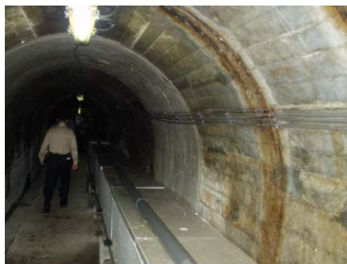
観測壕の内部 伸縮計の覆いの箱が見える
