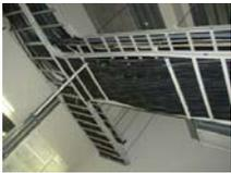
ケーブルラック小桁の脱落
