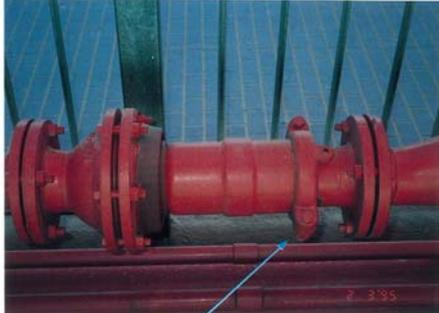
塗装の傷により激しく伸縮したことがうかがえる。
