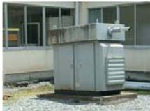
発電機基礎の沈下
