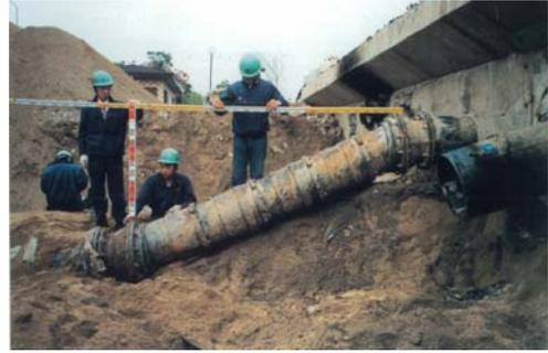
[測定結果]沈下量: 1,100mm、伸縮量: 170mm (伸び方向)
