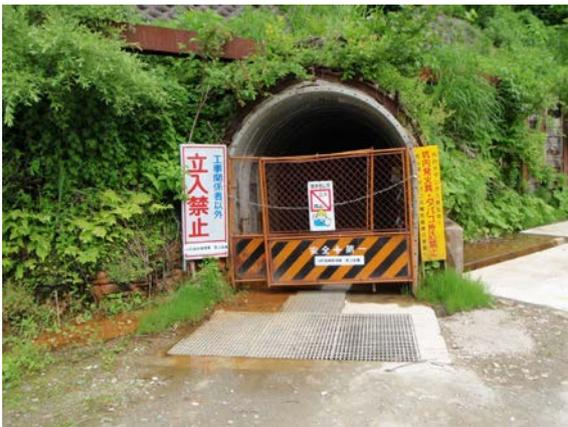
P 7-2 南山地すべりの末端に施工されている集水トンネル。毎分1トン程度の排水がなされている。
