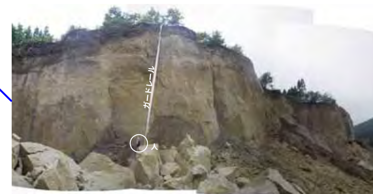
中腹部の滑落崖（ガードレールが垂れ下がり、道路が寸断された）
