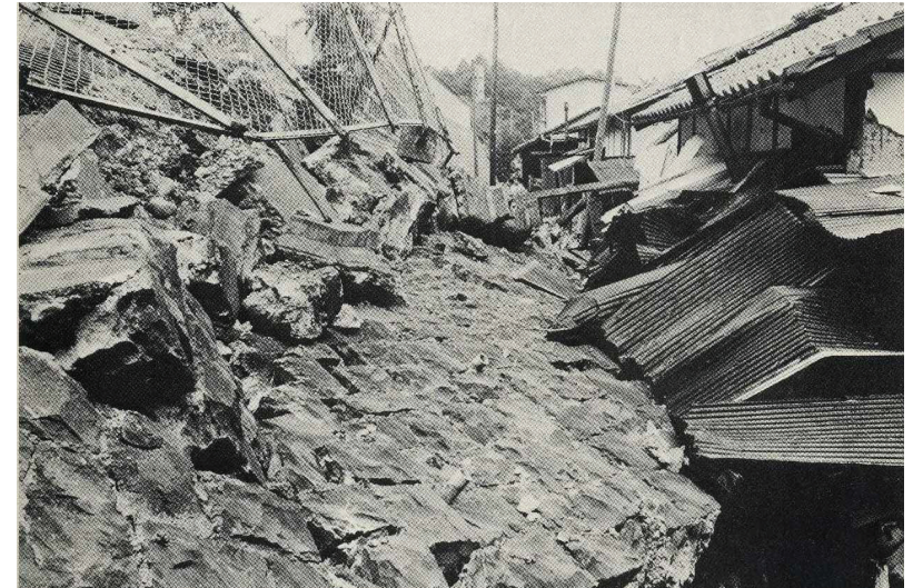
家まで押し潰した石垣(市内 高松)
