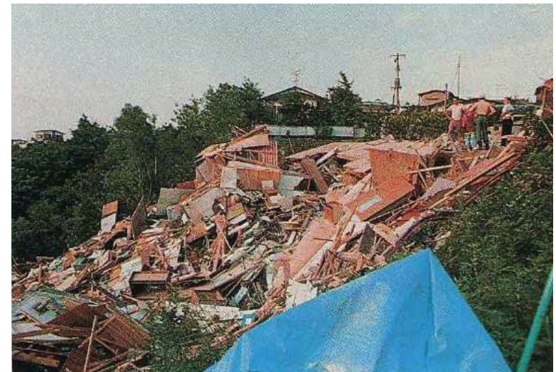
木造2階建てアパートの倒壊(市内 北根一念坊)
