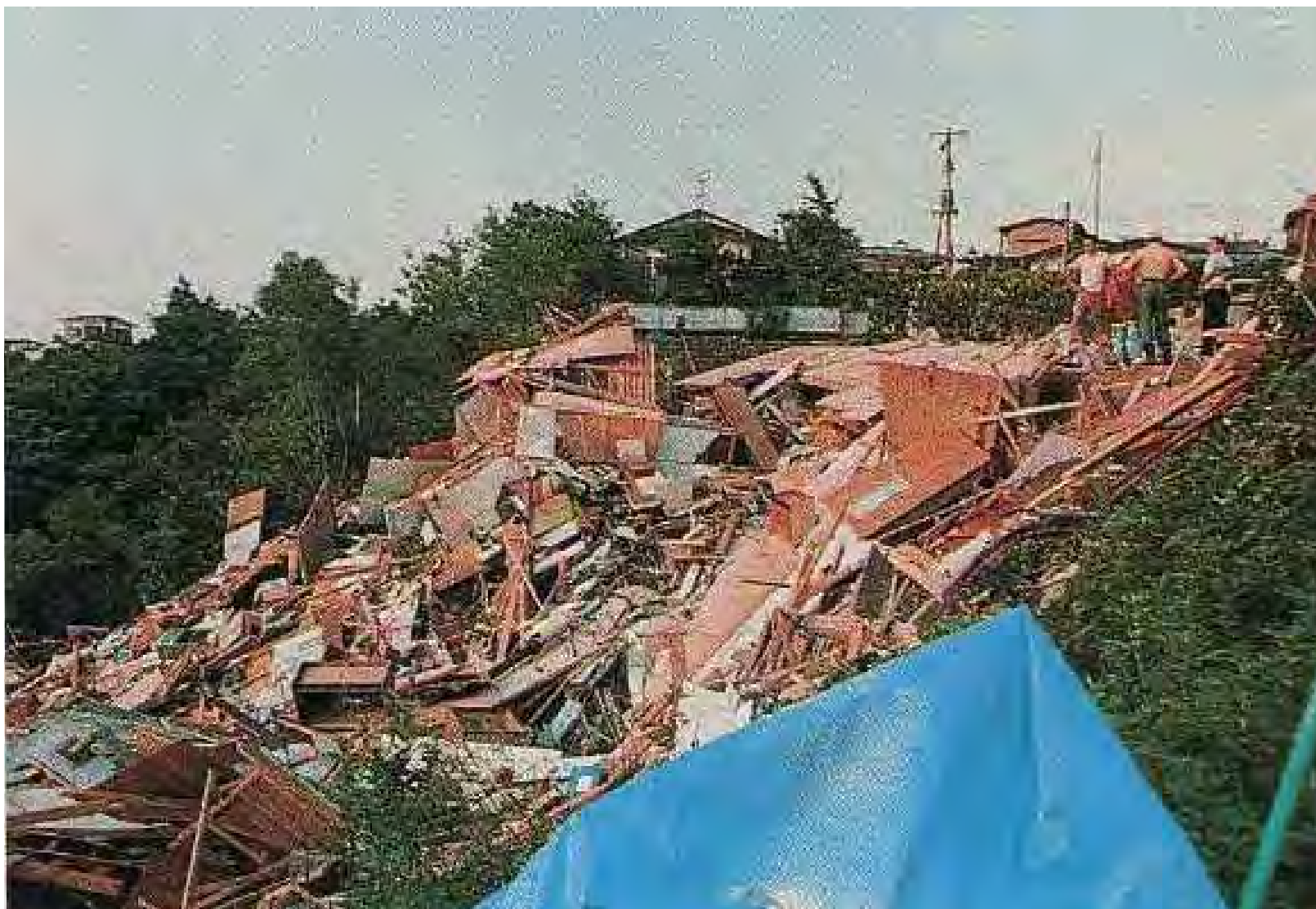
木造2階建てアパートの倒壊 (市内 北根一念坊)
