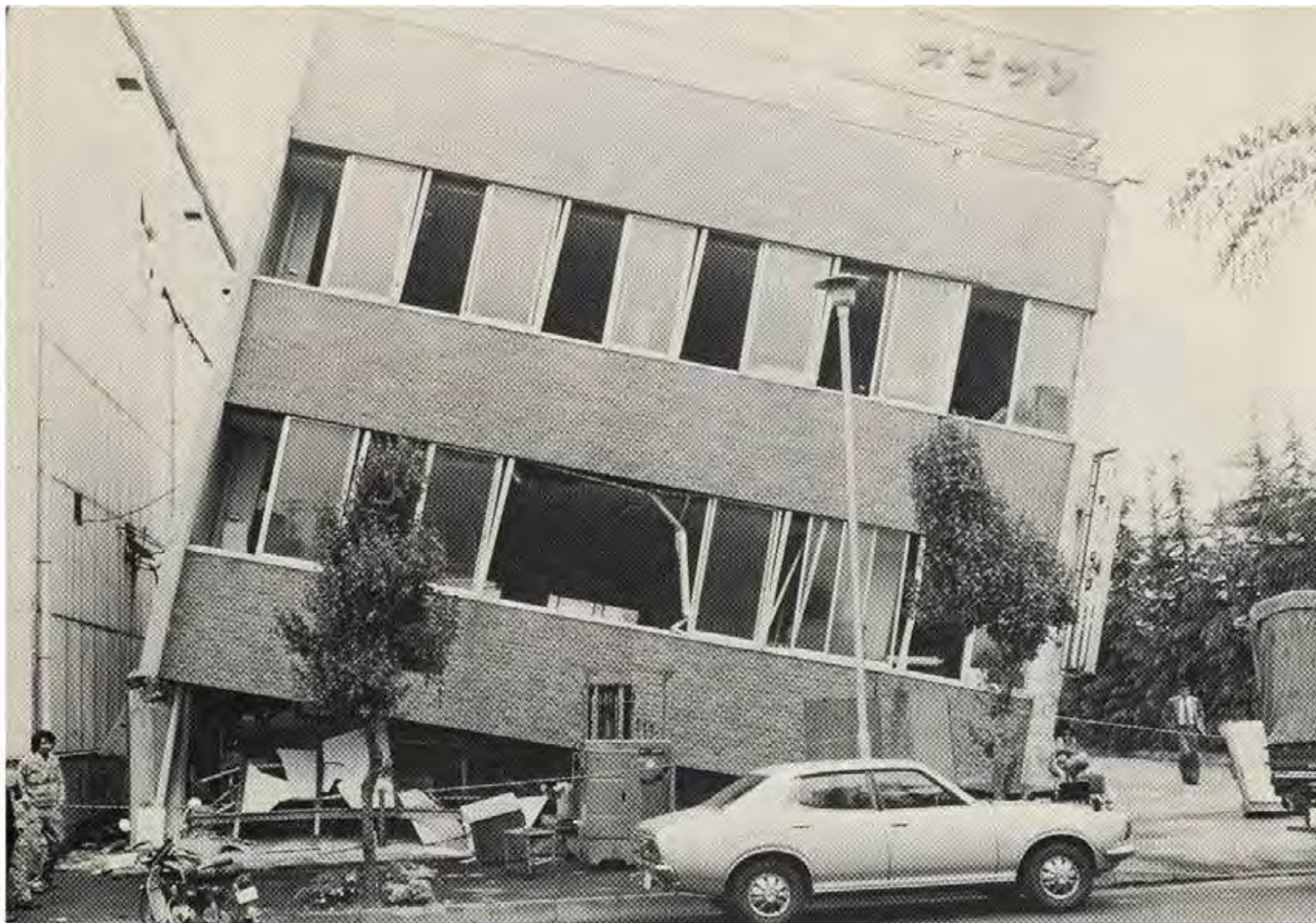
1階が完全に潰れ傾くビル (市内 卸町・苦竹)
