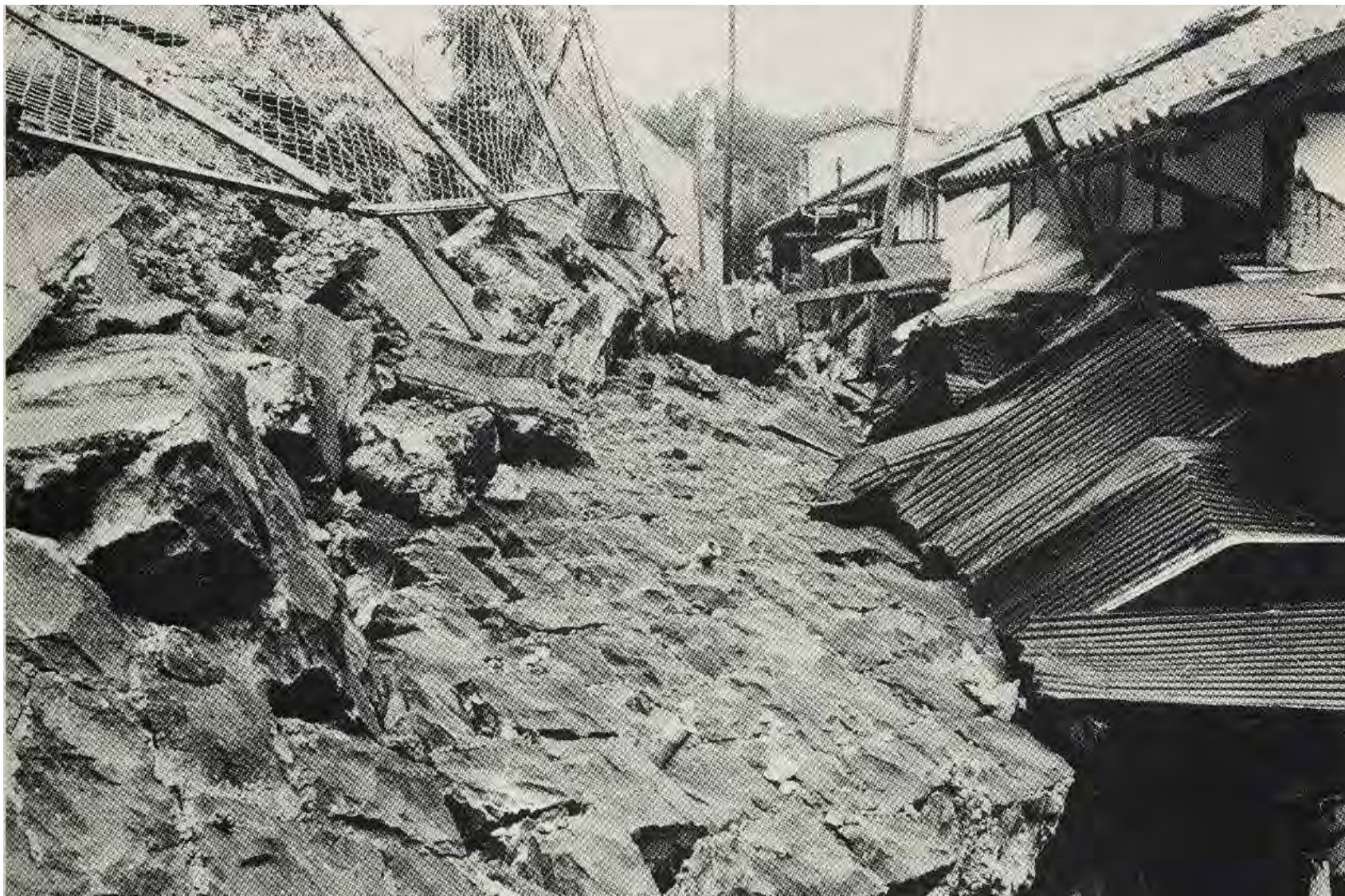
家まで押し潰した石垣 (市内 高松)
