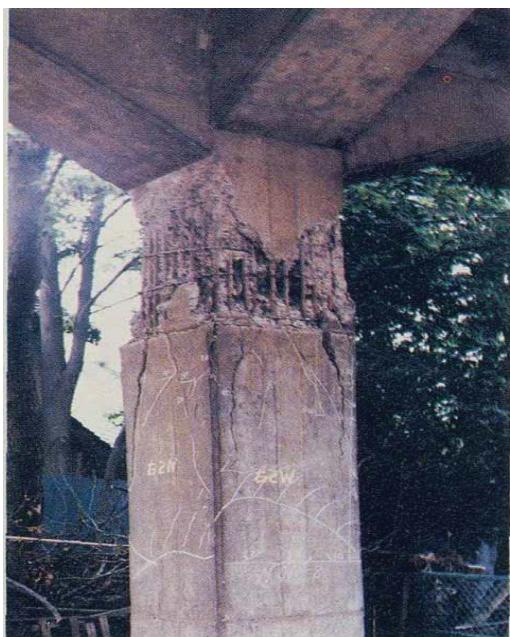
東北(貨物)線長町・宮城野間行人塚高架橋の柱頭部変状(コンクリートの亀裂・剥離、鉄筋の露出)。
