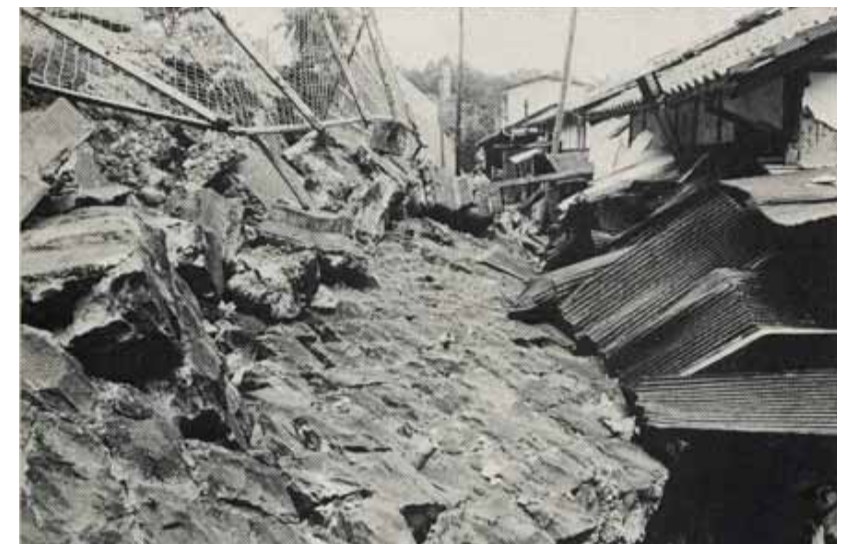
家まで押し潰した石垣(市内 高松)
