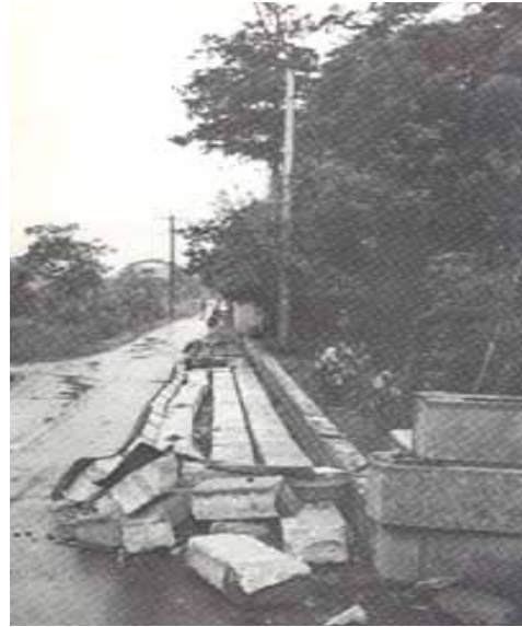
県内各地で門柱やブロック塀が倒れ、痛ましい犠牲者を出した。
