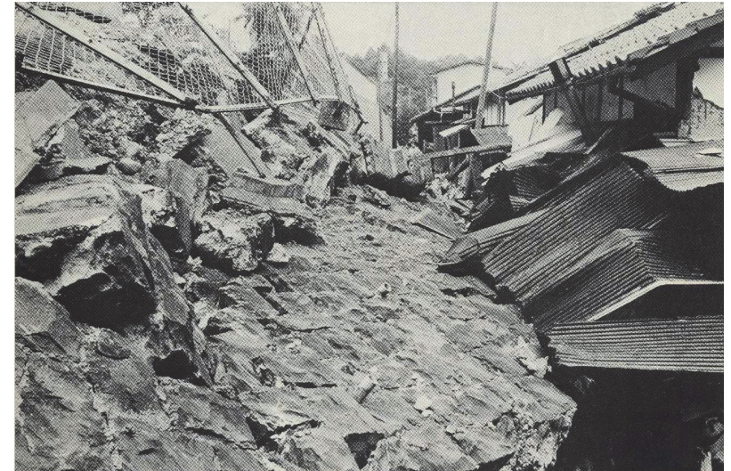
家まで押し潰した石垣(市内 高松)
