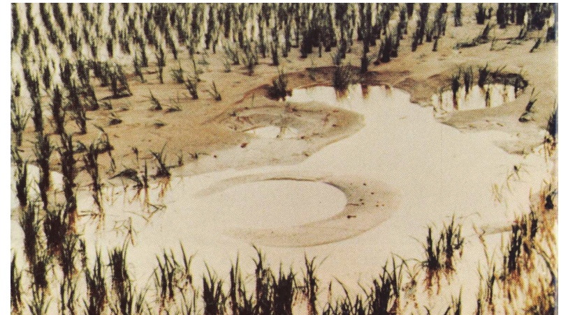
砂地盤の液状化による噴砂
