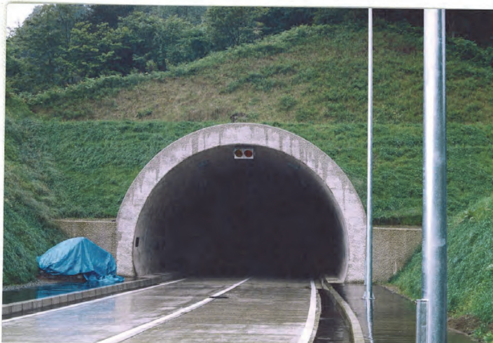
終点側 坑門工
