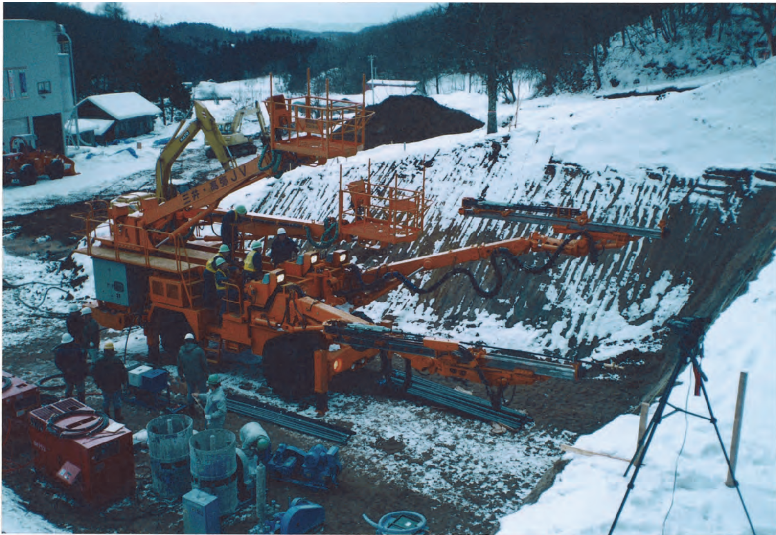
施工機械配置完了
