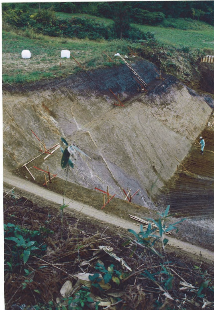
終点側の切土にみられる地質
