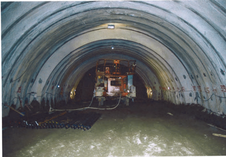
トンネー次覆工の状況 (先行断面の拡幅状況)
