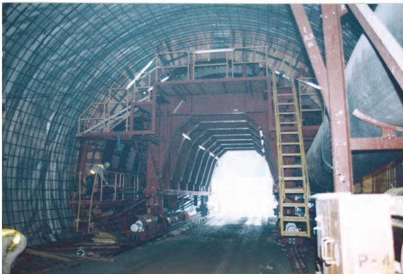
二次覆工ライニングコンクリート施工中 覆工施工状況
