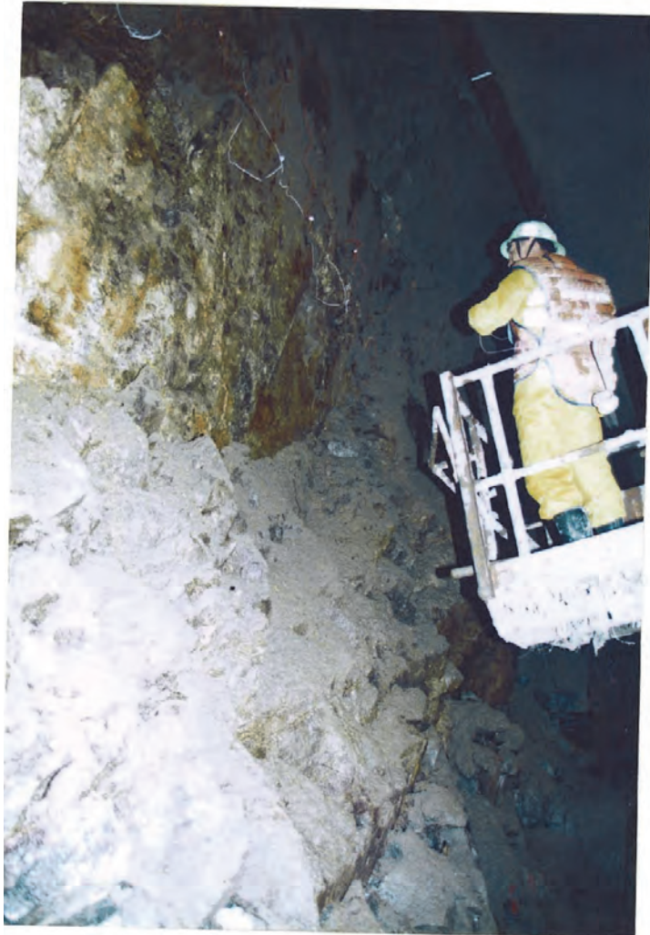
爆薬挿入結線作業
