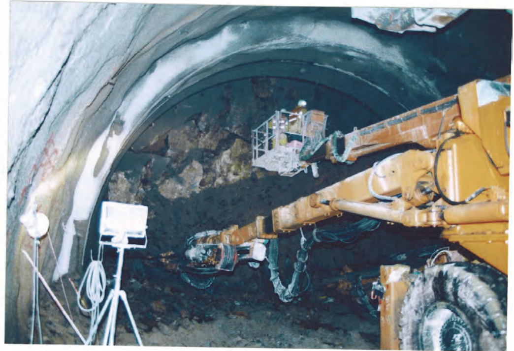
発破孔穿孔作業
