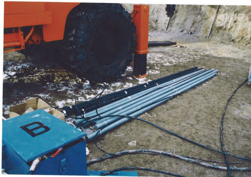
鋼管内 挿入管 手前塩ビ管
