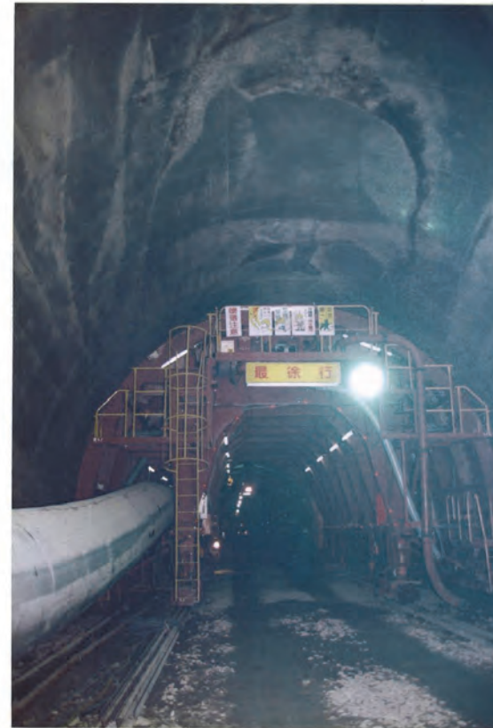
二次覆工ライニングコンクリート施工中 覆工施工状況
