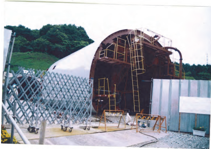
セントル入坑
