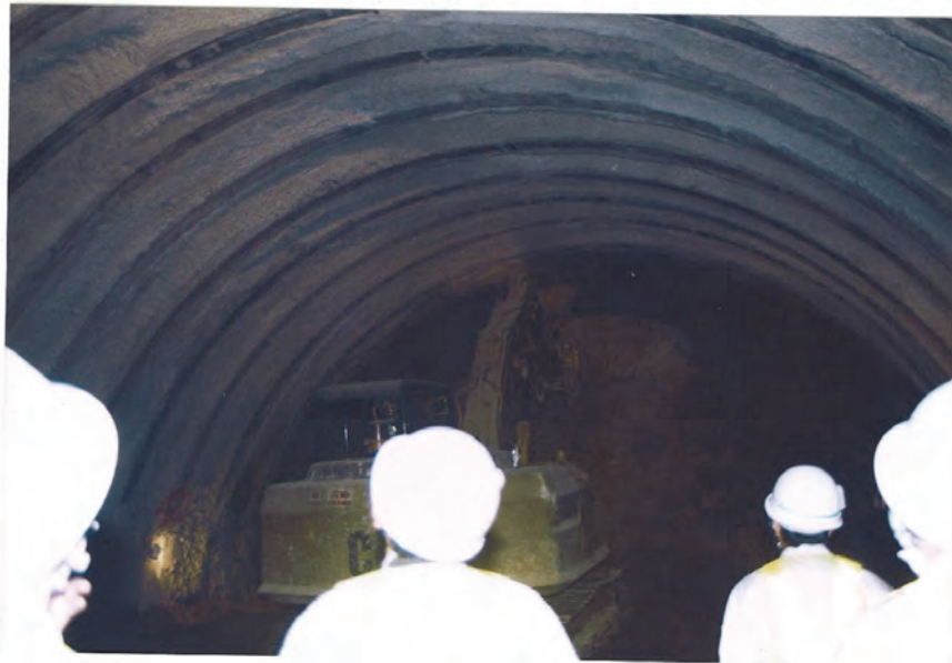
片押しのため終点 坑口への貫通間近 である
