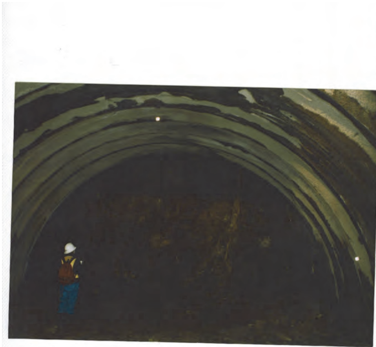
地山劣化区間 C II パターンに変更
