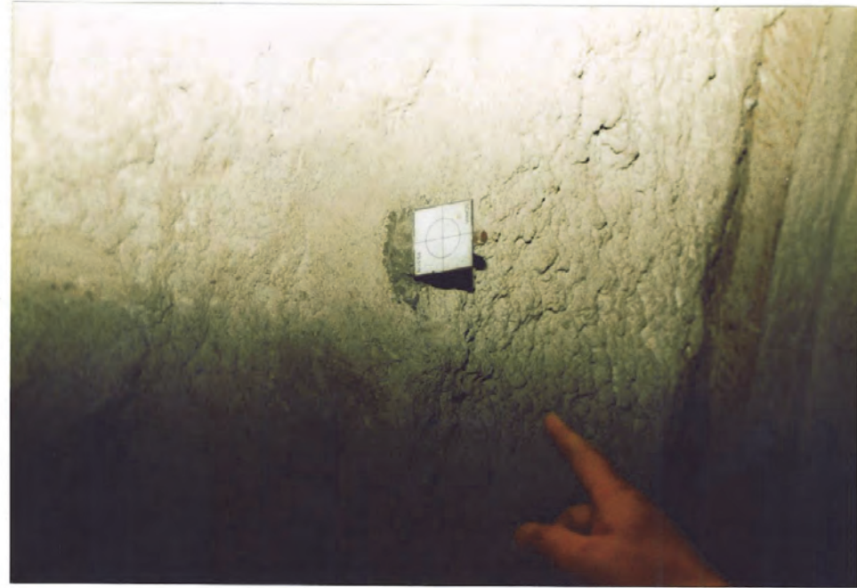
内空変位計測ターゲット 〔管理基準値を設定〕
