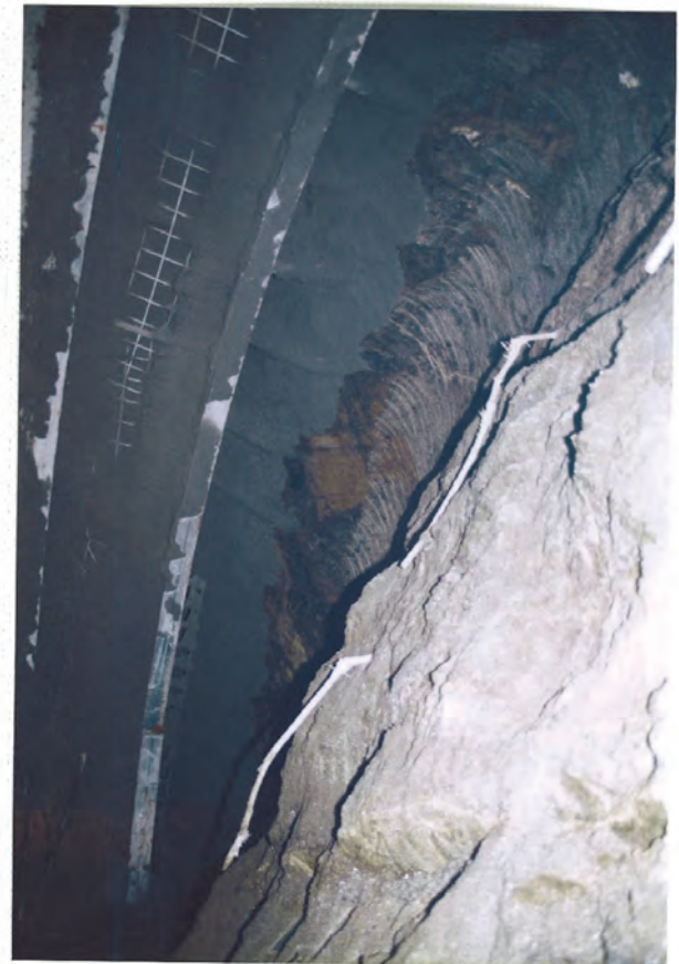
核残しで切り羽鏡に ファイバーボルト施工
