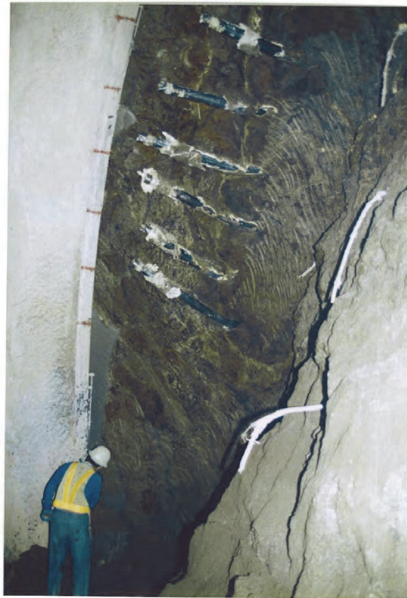
AGF施工吹付前
