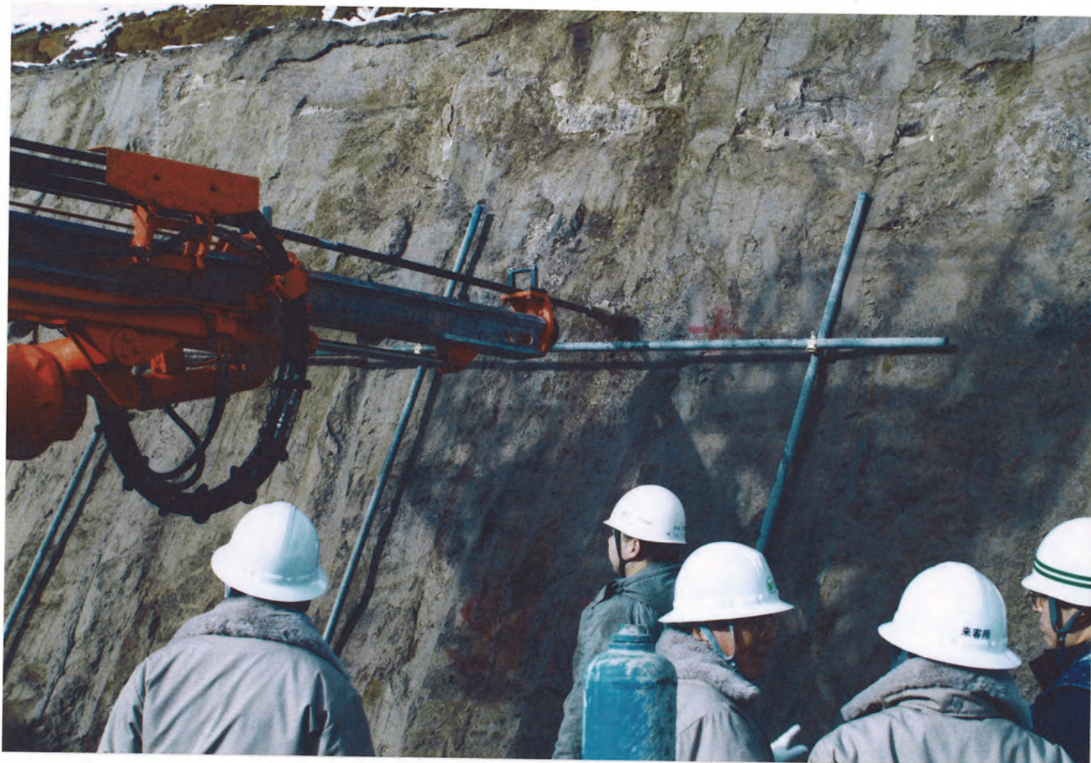
鋼管挿入孔削孔
