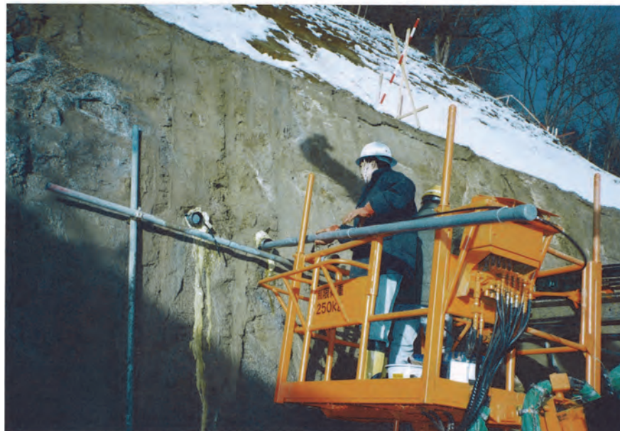
インサート管挿入 黒いパイプはエア 抜きパイプ
