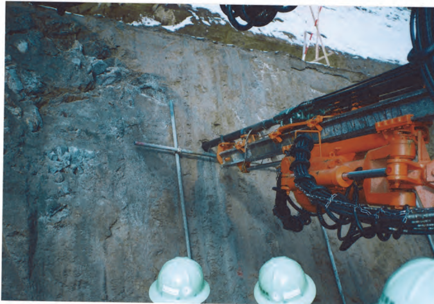
先導鋼管挿入中
