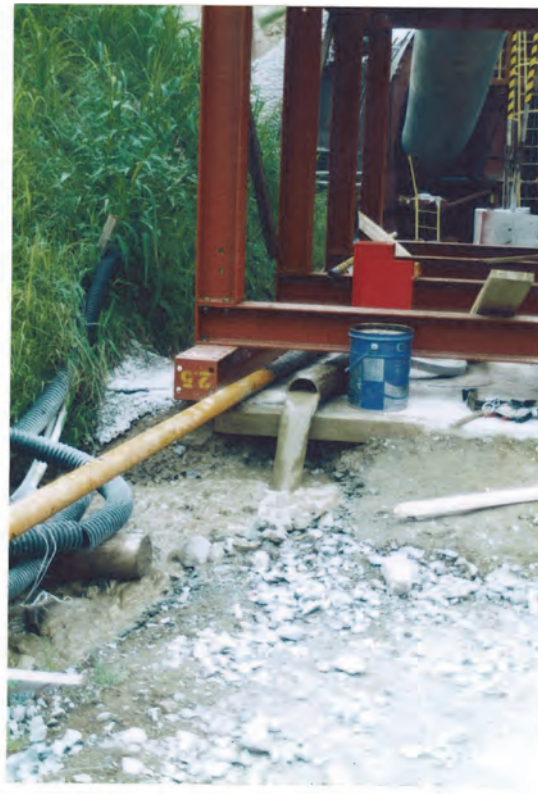
破砕帯区間での湧水 0.5t/分
