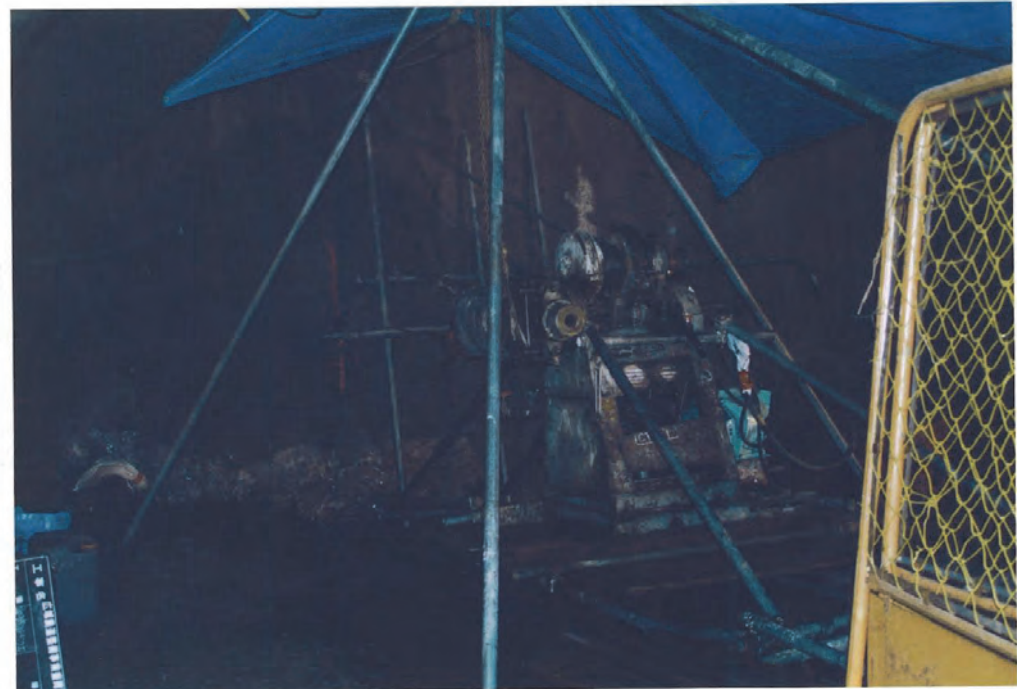
水平ボーリング状況(湧水多くなる)
