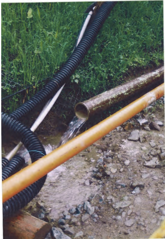
破砕帯区間前の 湧水
