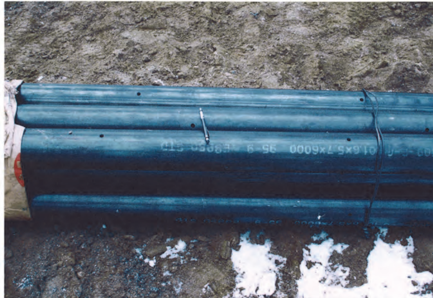
挿入用鋼管 \Phi 101.6\text{mm} t=4.2\text{m}
