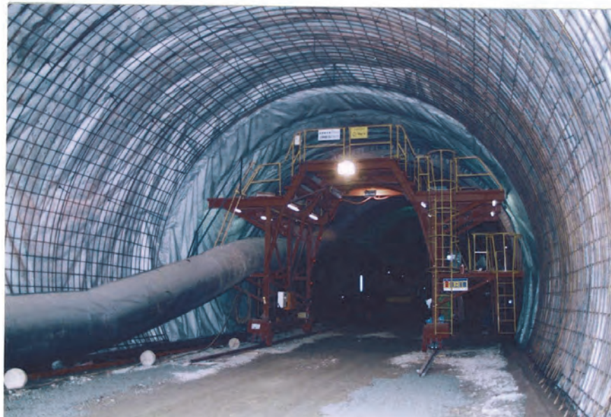
起点側より坑口部 DⅡパターン 防水シートの上に鉄 筋組立
