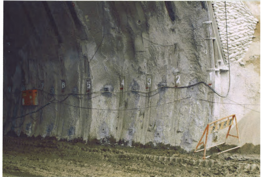
下半部施工状況
