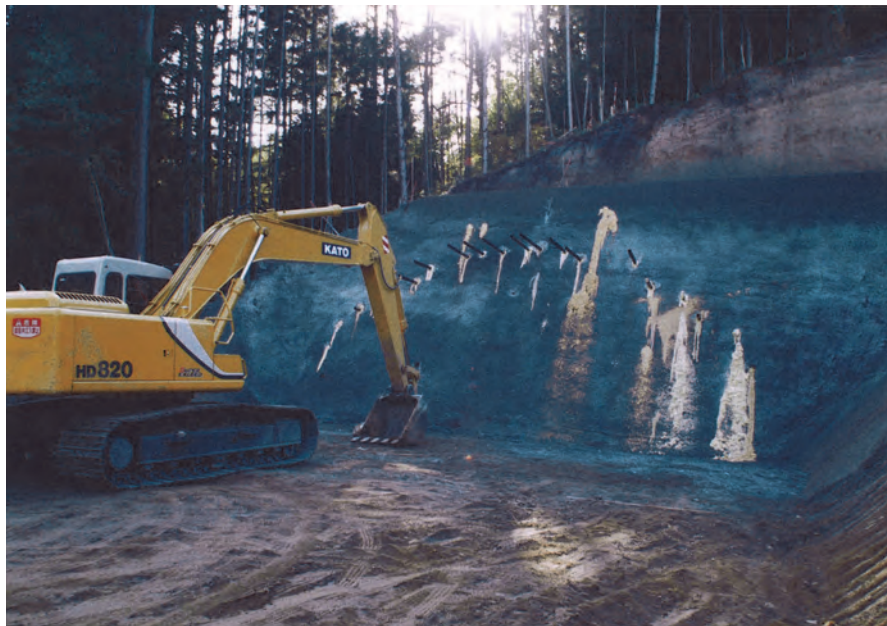
終点坑口側の状況
