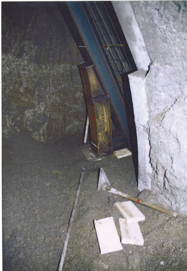
明かり巻部のウイングリブ施工
