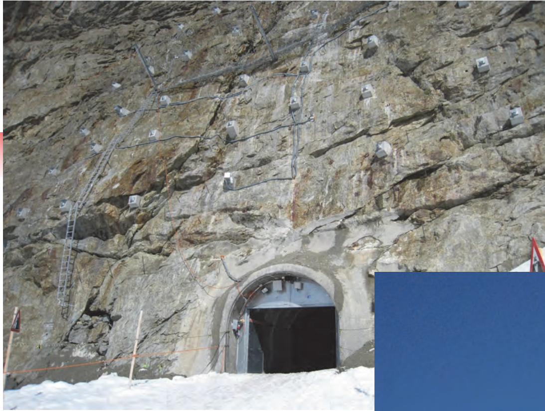
ユングフラウヨッホ のトンネル坑口とア ンカーと落石ネット による斜面对策工
