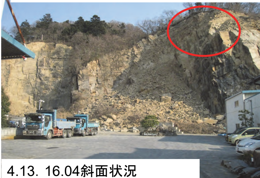
稲井地区岩盤斜面の変状継続変化
