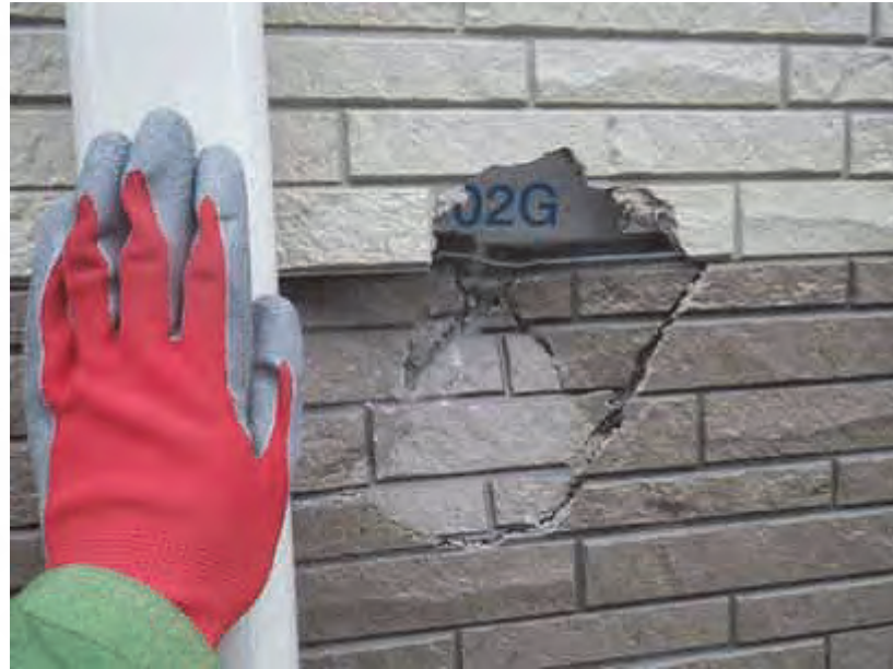
20cm大の飛び石によるGH希慈 の建物外壁の破損
