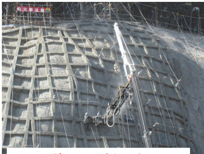
ロックボルト孔削孔中
