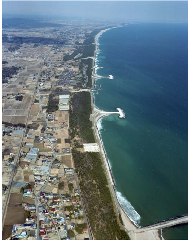
津波前(2010年3月撮影) 深刻な海岸侵食、T型突堤、養浜
