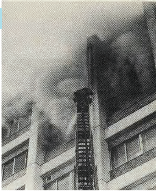
薬品が倒れ火災発生 東北大 理学部の化学棟(市内 青葉山)
