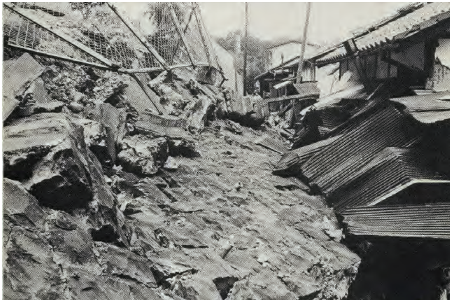
家まで押し潰した石垣(市内 高松)
