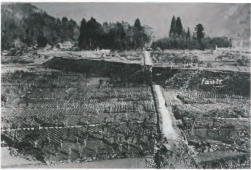
白い部分は道でしたが、断層のズレ(正断層)で段差ができてしまっています
