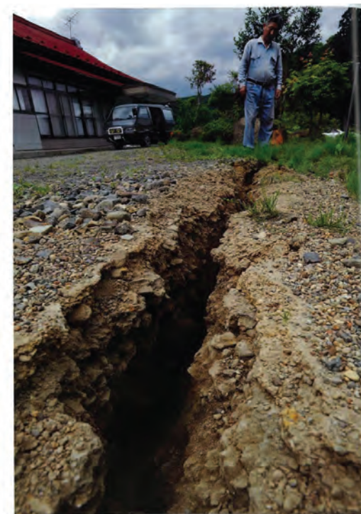
地震によって地盤の露出にできた大きな地割れ =14日午後2時ごろ、震源地東北沖ノ原
